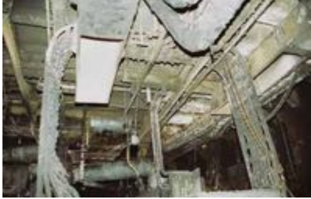
보조 발전기에서 시작된 화재가 케이블 트레이를 통해 멀리 있는 곳까지 확산된 모습
