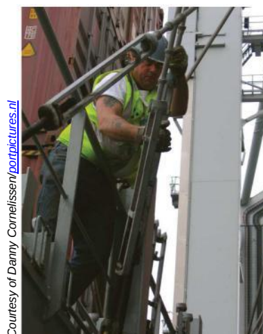
図 41.28: ターンバックルの締め付け
