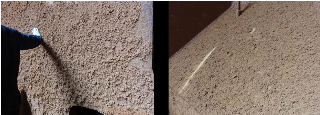
Señales de salpicaduras de bauxita
